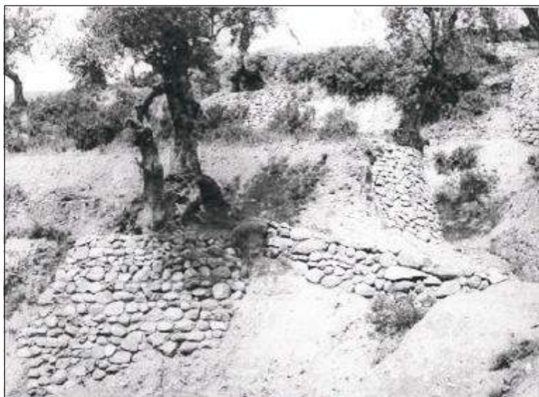
Un'area boschiva Sotto: sistemazione del terreno con muretti a secco
